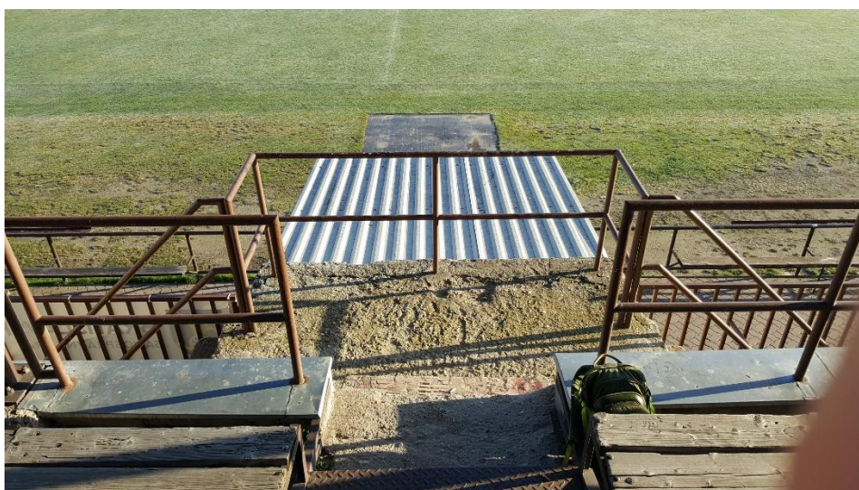
Obr.č.4 Pohľad na podestu
