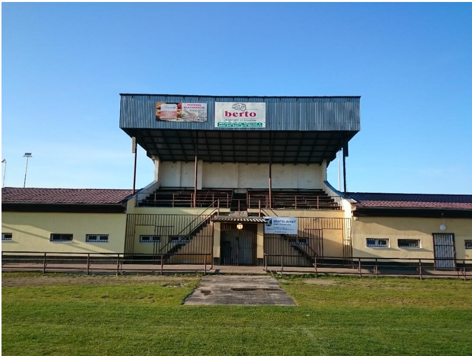
Obr.č.1 Pohľad na tribúnu
