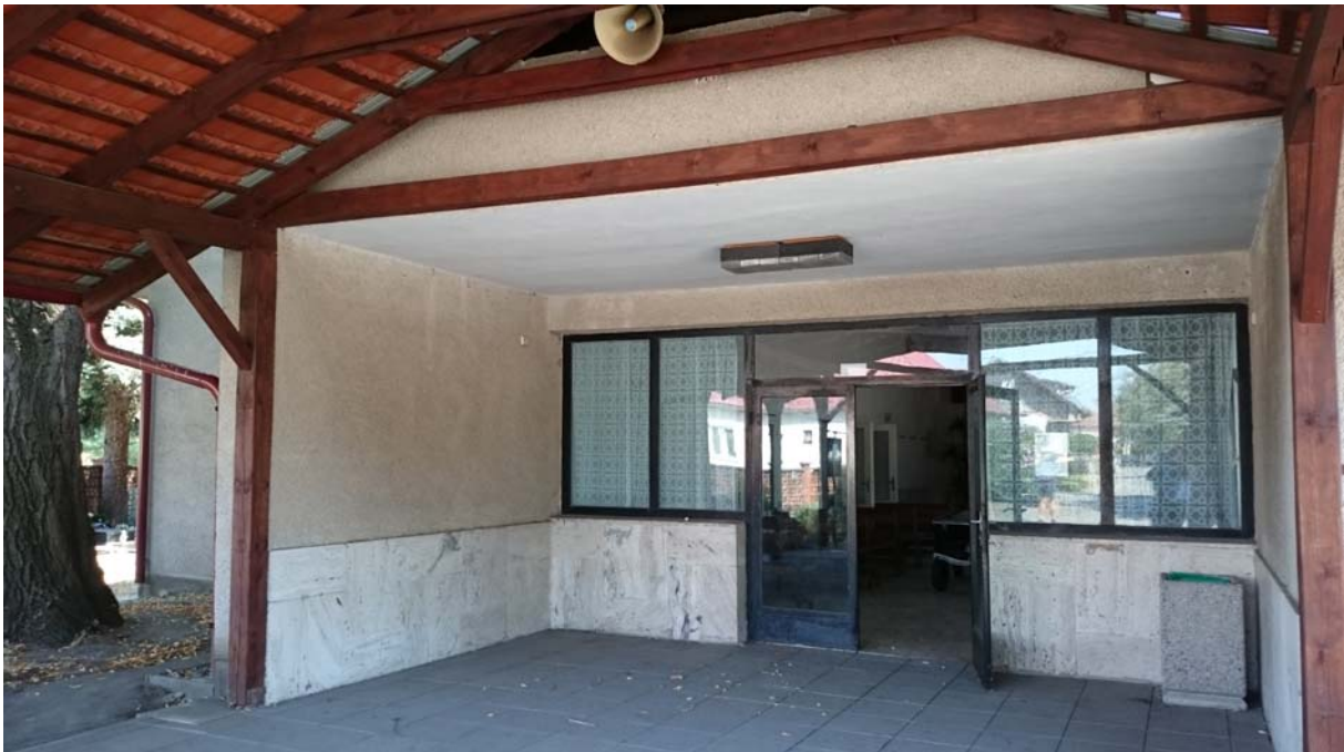
Obr. č. 1: Pohľad na vstup zo západnej strany
