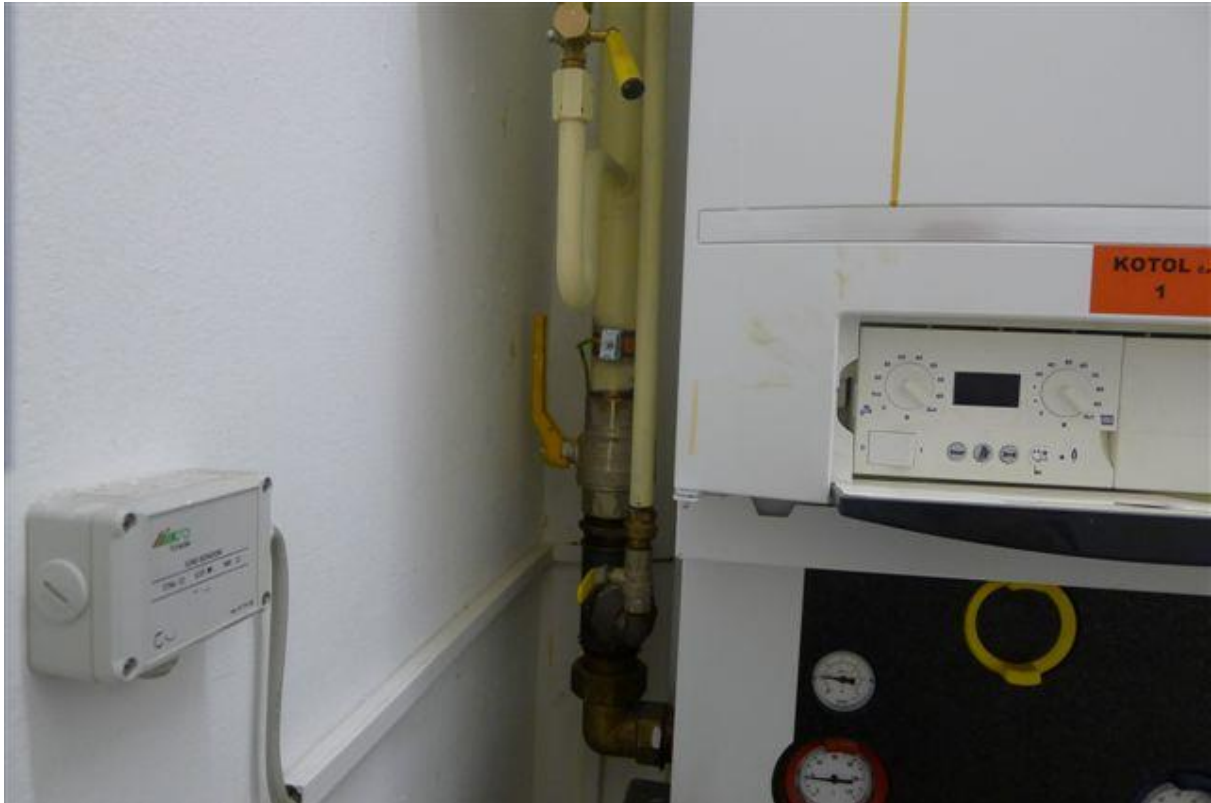
Obrázok č. 17 – M.č.1.05 – kotolňa, detail uzáveru plynu
