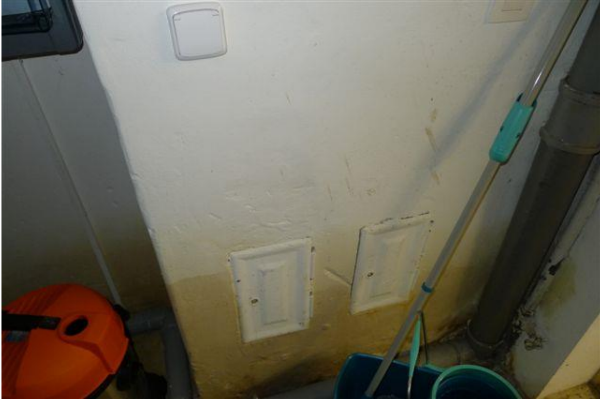
Obrázok č. 11 – M.č.1.02– strojovňa vzduchotechniky – čistiace otvory komínov
