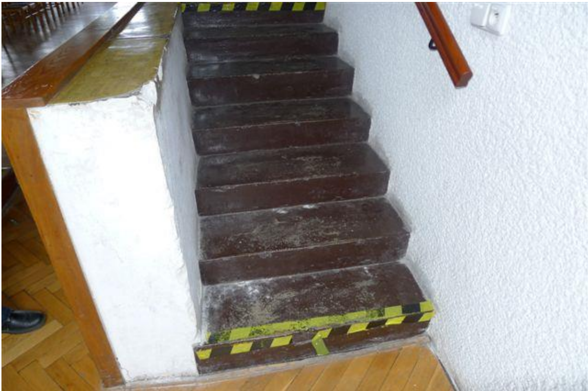
Obrázok č. 26 – M.č.1.18 – spoločenská sála – detail schodov na pódium
