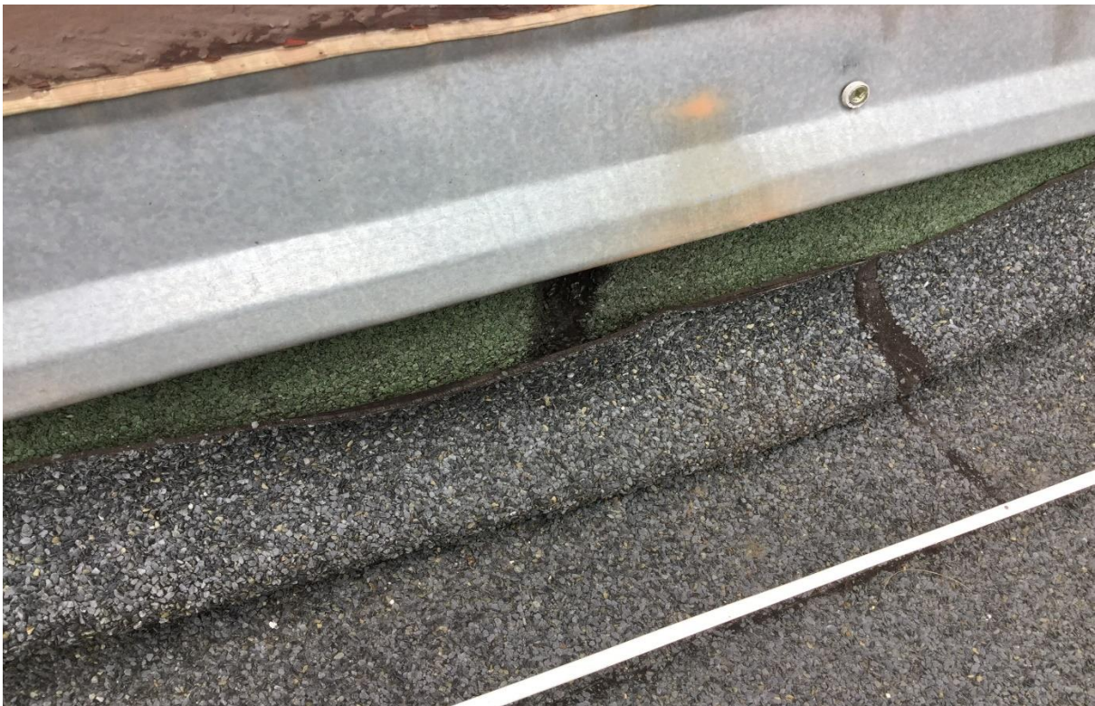
Obrázok č. 64 – strecha pultová –Izolácia na niektorých miestach atiky nie je dostatočne uchytená k podkladu, padnutá
