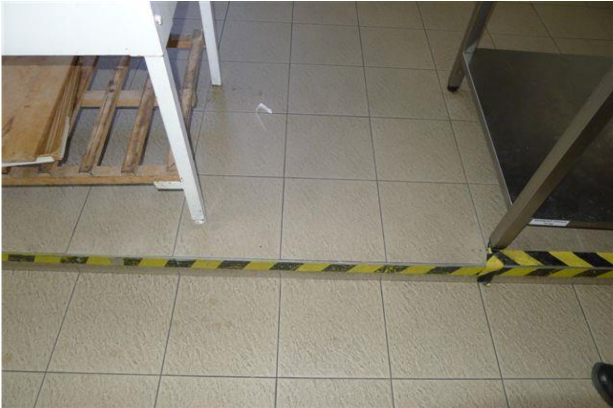
Obrázok č. 45 – M.č.2.10 – kuchyňa – detail protišmykovej dlažby (vyhovuje požiadavkám zaťaženia)
