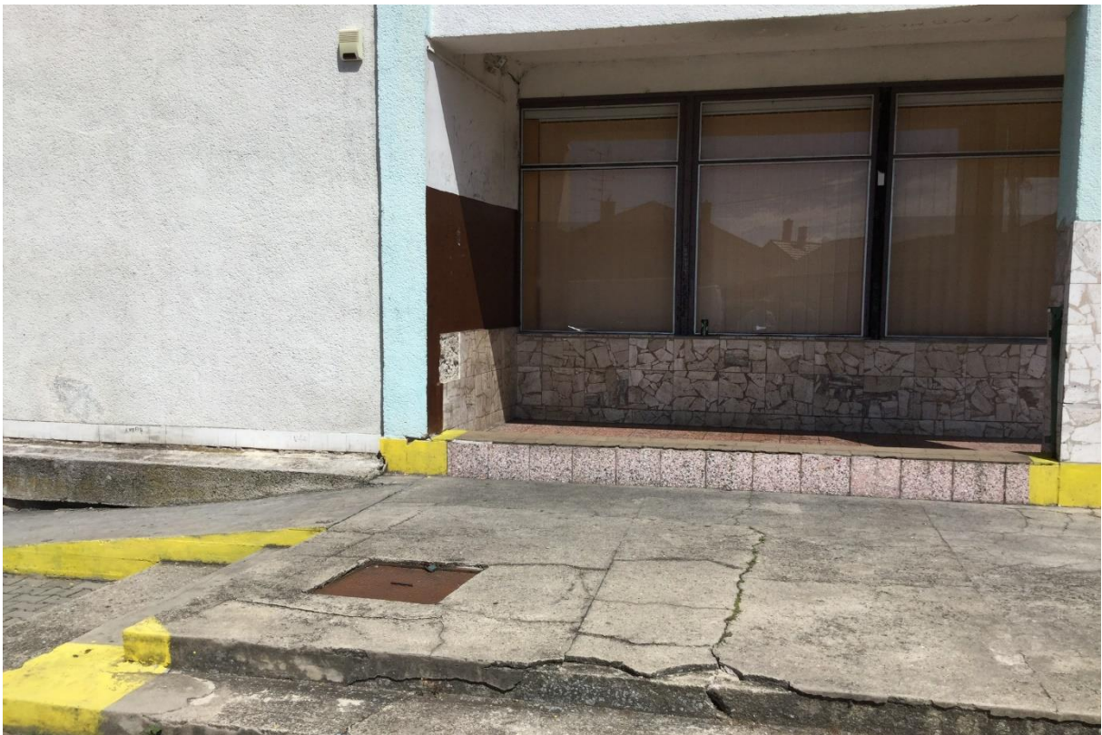
Obrázok č. 72 – Plocha pred objektom riešená z betónového poteru, poter popraskaný a špinavý
