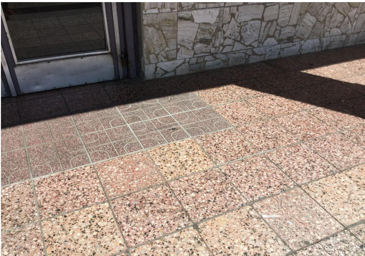
Obrázok č. 74 – Vybudovanie čistiacej rohože, vyspádovanie podlahy od objektu
