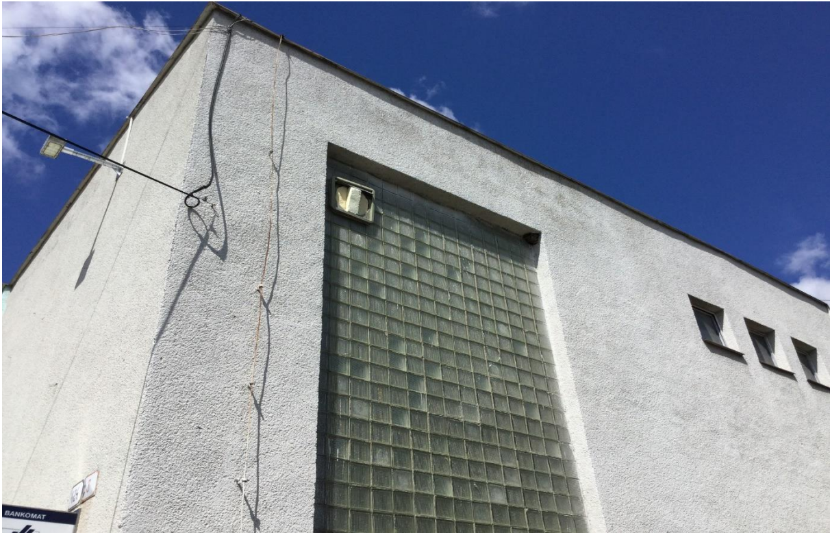
Obrázok č. 69 – okná a dvere – stena zo sklobetónu po životnosti
