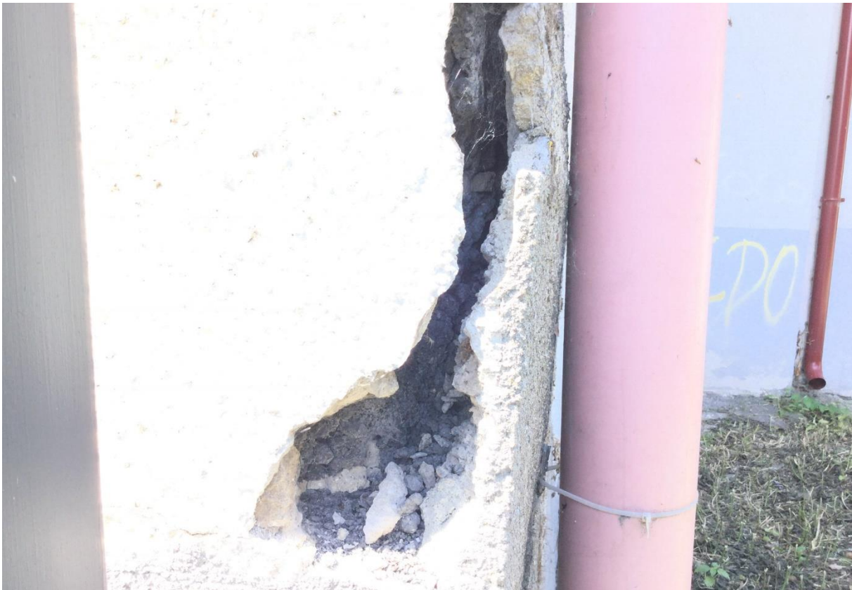
Obrázok č. 56 – východná – omietka prasknutá vplyvom poveternostných podmienok a slnečného žiarenia
