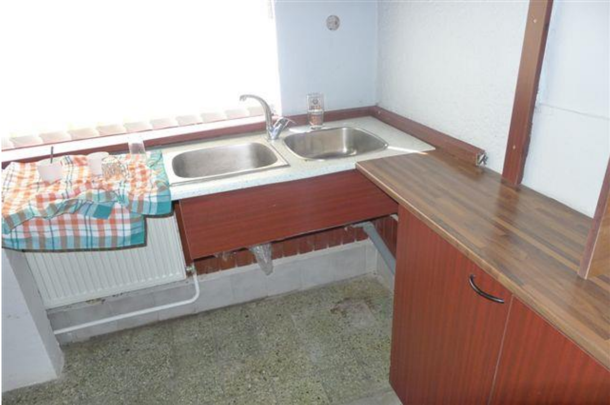
Obrázok č. 41 – M.č.2.08 – výdajný pult - v reštaurácii, dlažba nie je protišmyková, treba ju vymeniť alebo upraviť
