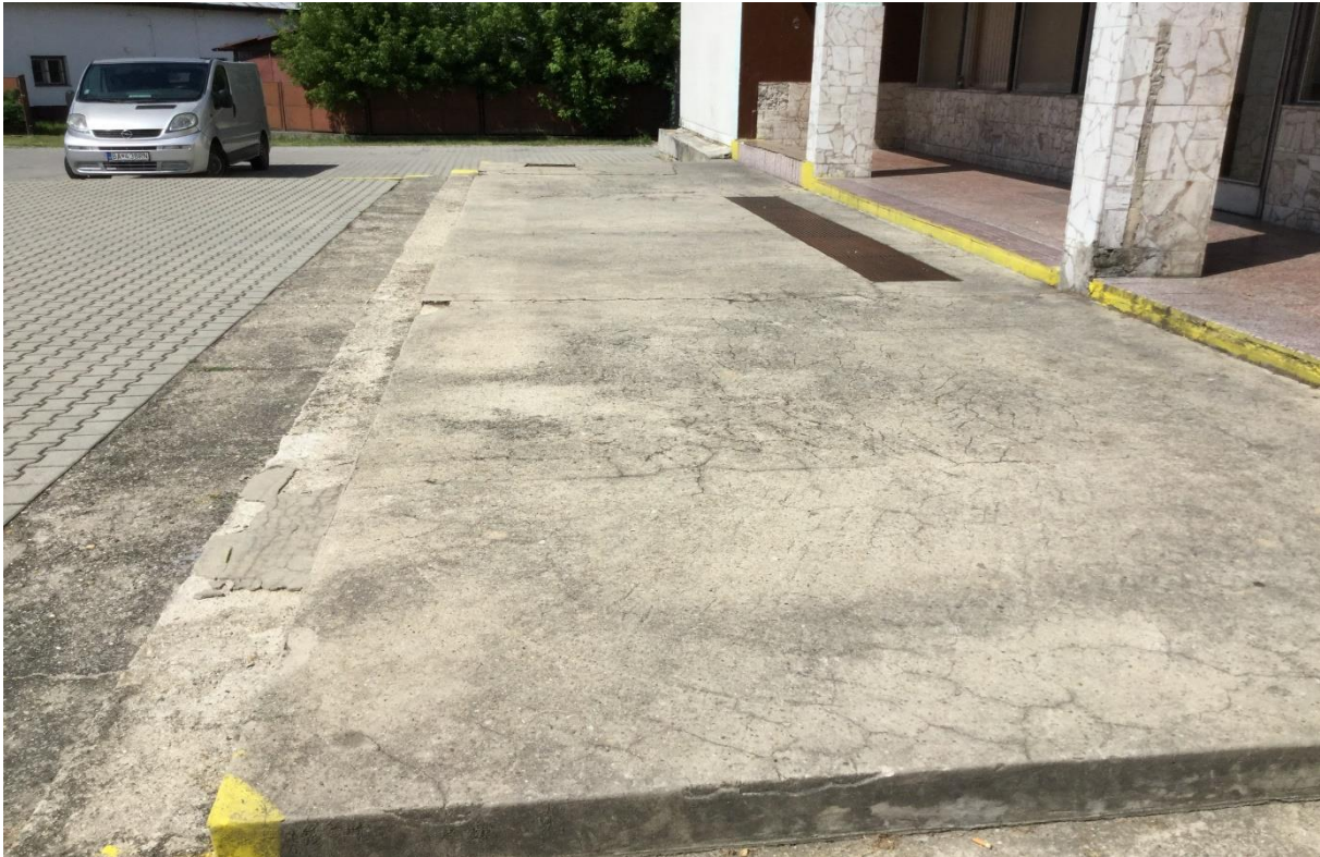
Obrázok č. 73 – Vybudovanie nájazdovej rampy bezbariérového prístupu objektu
