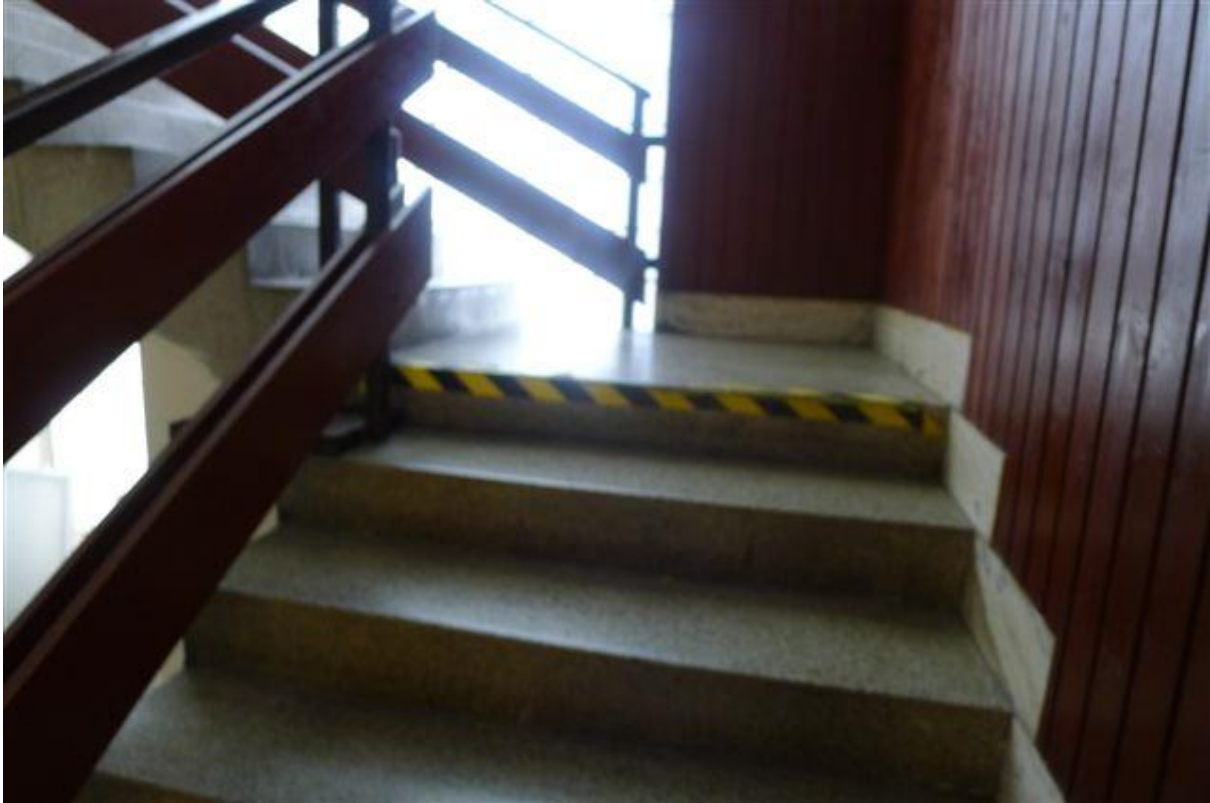
Obrázok č. 19 –M.č.1.14 – chodba-schodisko – detail schodiska
