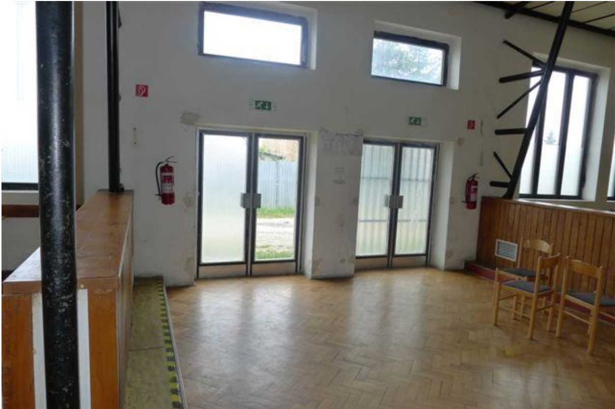
Obrázok č. 23 – M.č.1.18 – spoločenská sála – detail únikových ciest – povrchy stien si vyžadujú opravu
