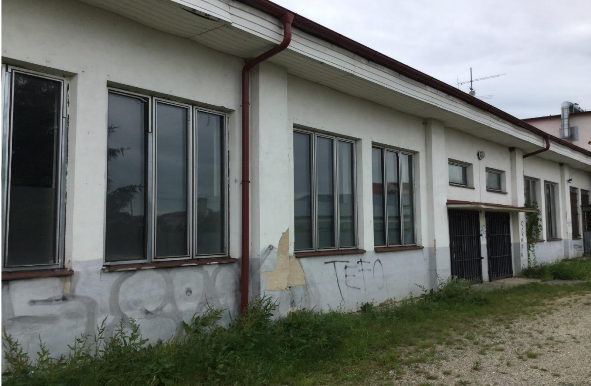
Obrázok č. 55 – západná fasáda – omietka na niektorých miestach opadaná vplyvom poveternostných podmienok a slnečného žiarenia
